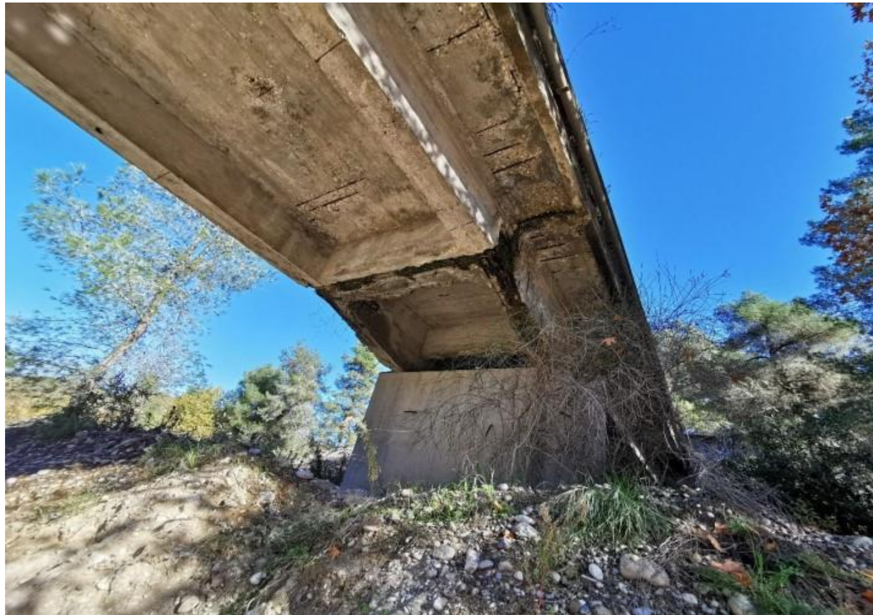
Δήμος Ιστιαίας - Αιδηψού Γέφυρα διάβασης ρέματος της ΕΠ.Ο. 26 Καμάρια-Κρυονερίτης -Μαρούλι δια Μονοκαρυάς
