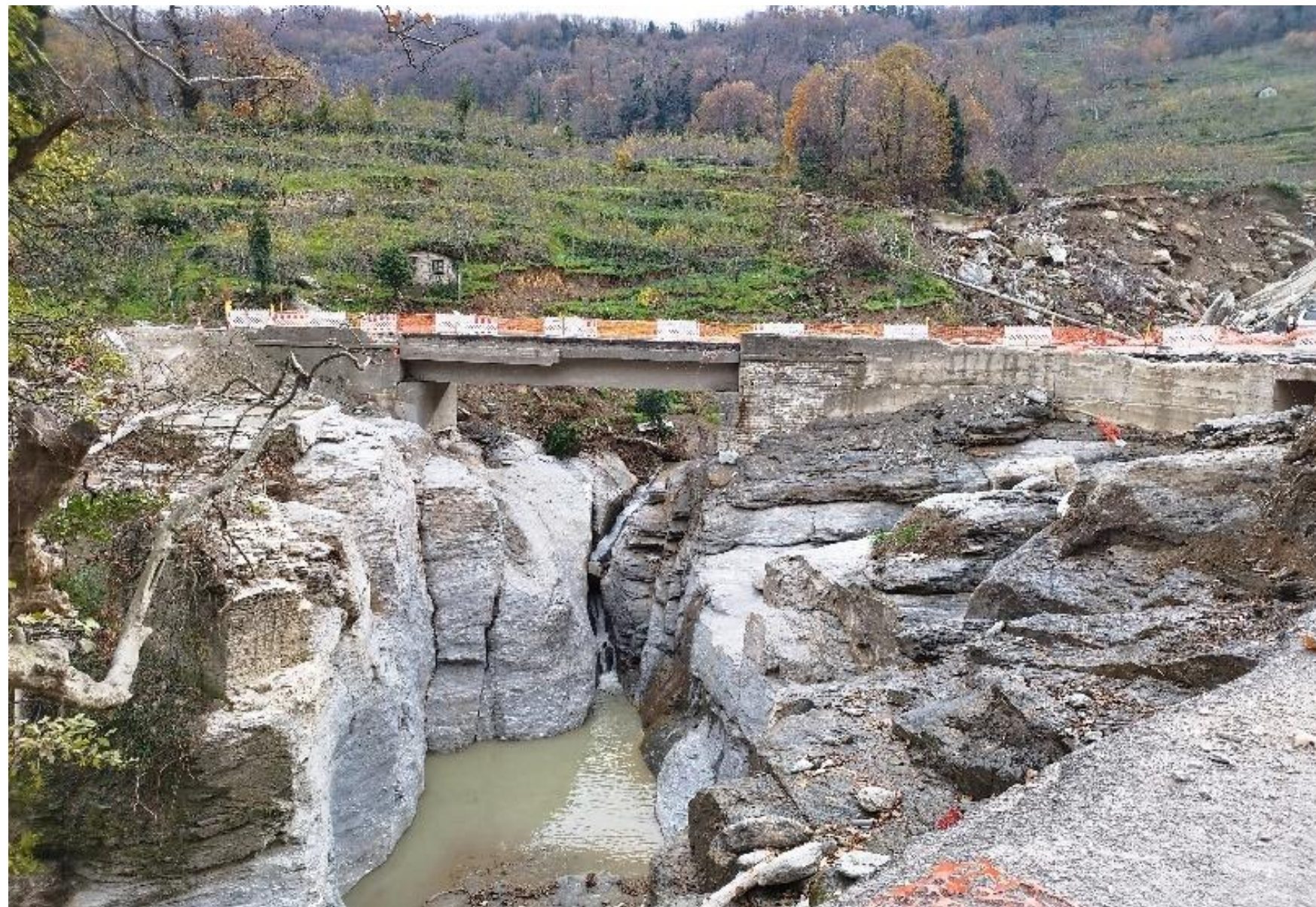
Δήμος Ζαγοράς Μουρεσίου Γέφυρα Γαλανορέματος
