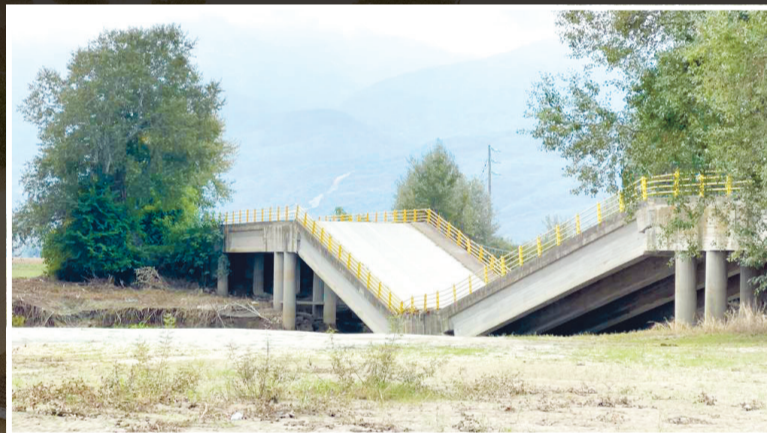
Φωτογραφία από το Δέλτα του Πηνειού. Οι εμπειρογνώμονες διαπίστωσαν ρηχή θεμελίωση, χωρίς πασσάλους, με αποτέλεσμα να πέσει η γέφυρα
